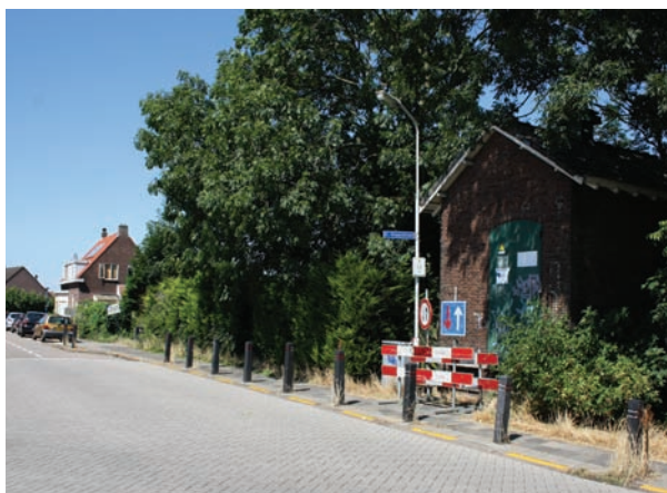
De wilde begroeiing rond het elektriciteitshuisje
