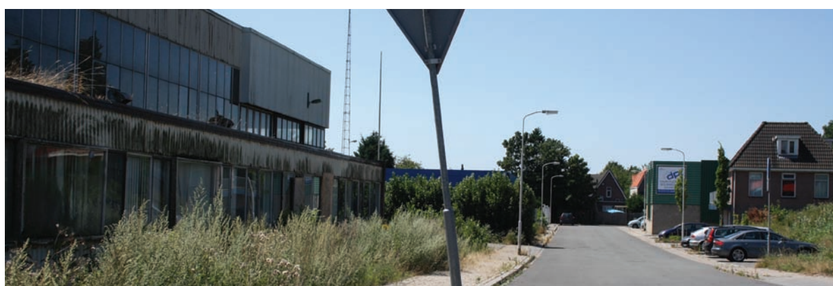
Leegstaande panden (nu gesloopt) en verwaarloosde openbare ruimte
